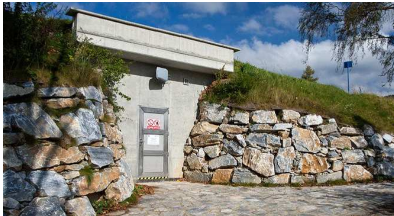
foto č. 3: vodojem http
