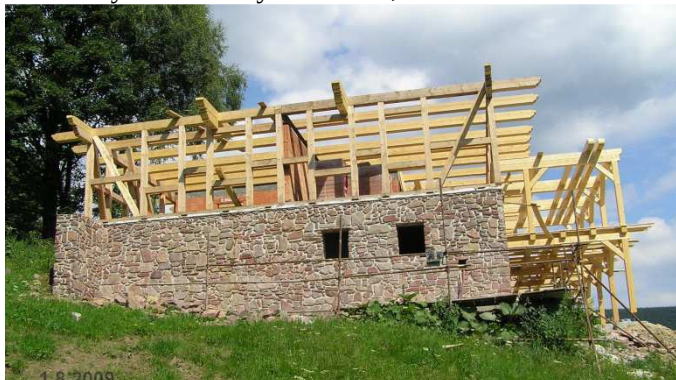
výstavba chaty Vindoška, Velké Vrbno
