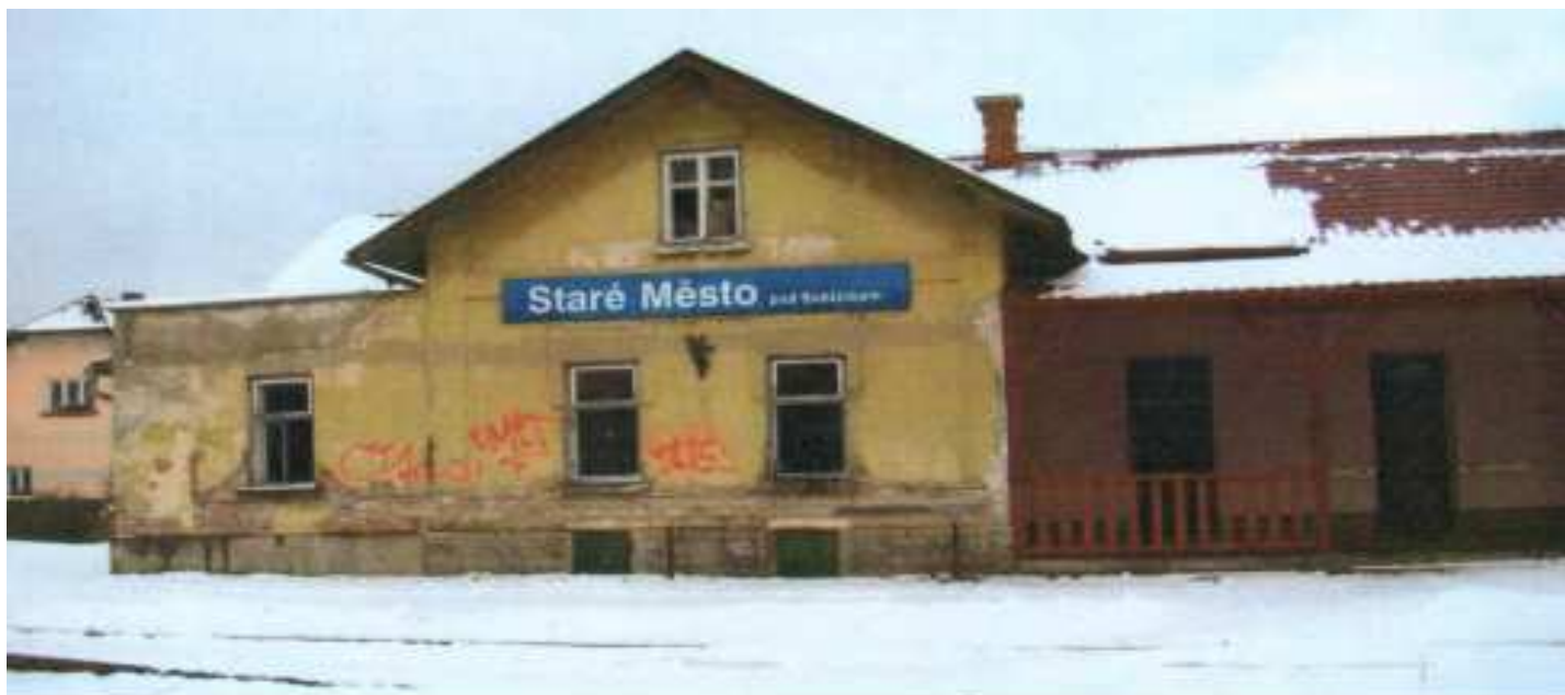
Budova nádraží před rekonstrukcí, rok 2005
