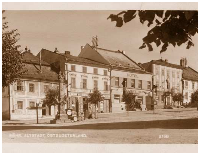
Čerpací stanice v proměnách času...
