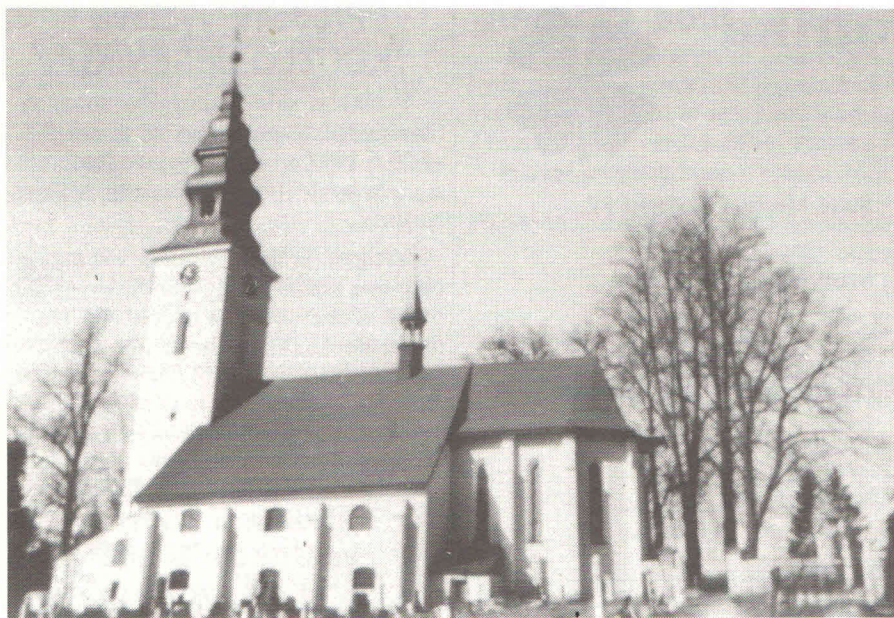
Pohled na kostel z jižní strany s oratoří a kněžiště.
