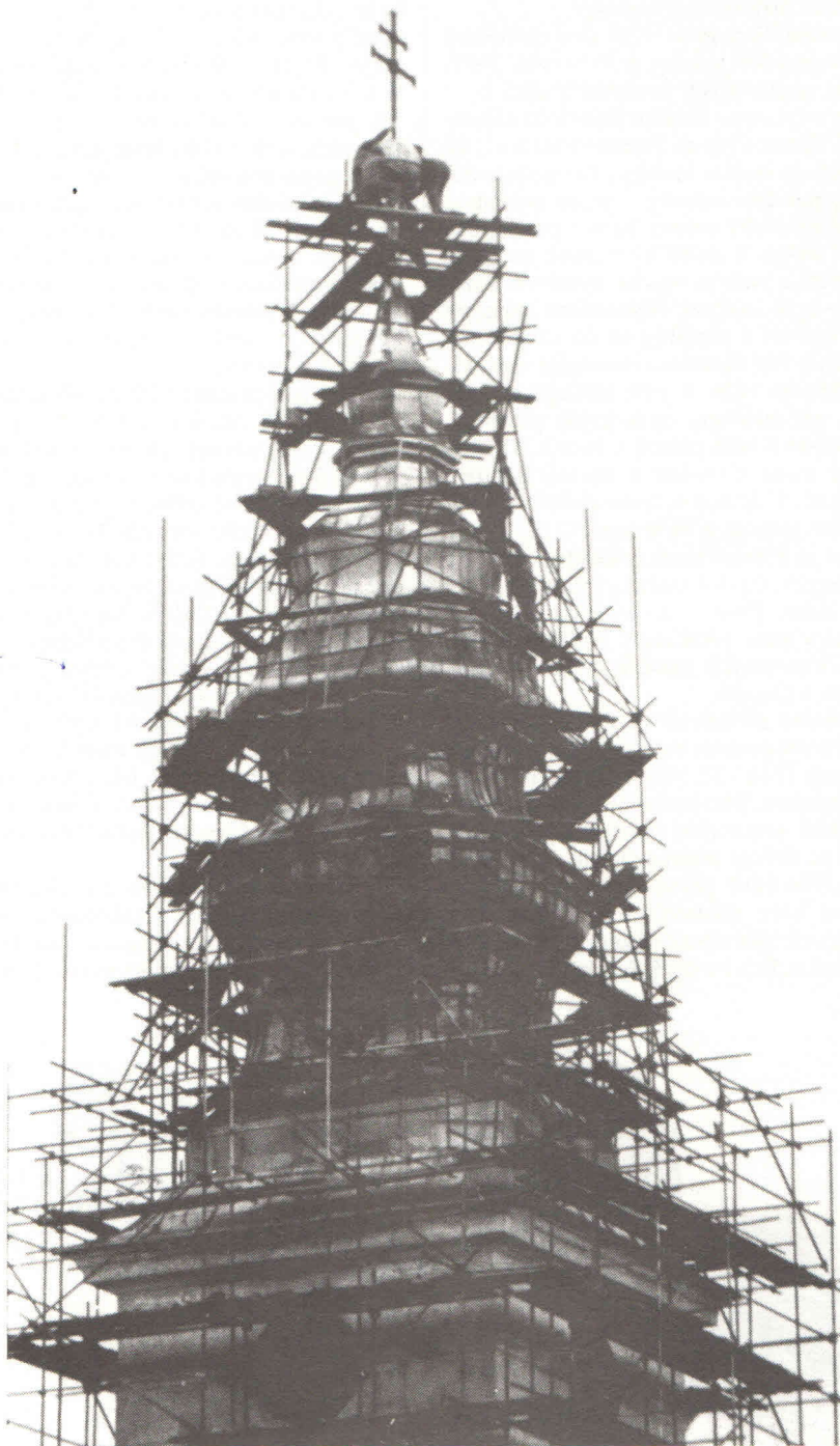
Postavit lešení při opravě věže je velmi náročná práce. Postavy u makovice přibližují její skutečné rozměry.
