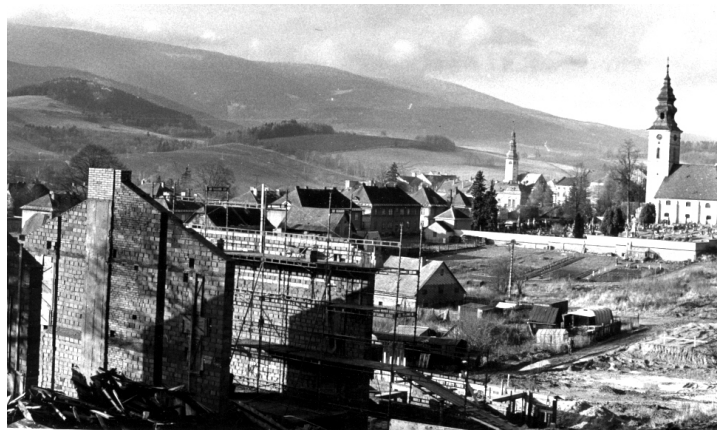
ulice Polní ve výstavbě...
