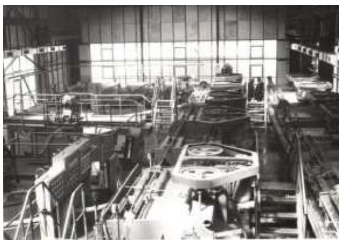
Flotační hala v nové úpravně
