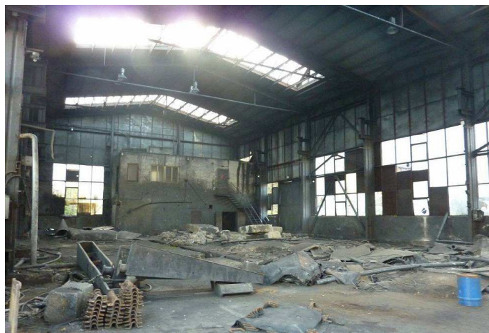
Demontáž technologie – r. 2012
