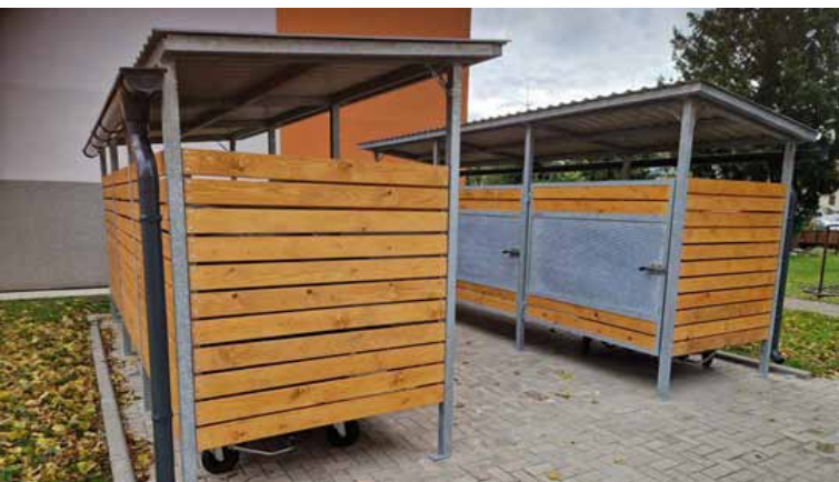
Nově osazené přístřešky na kontejnery
