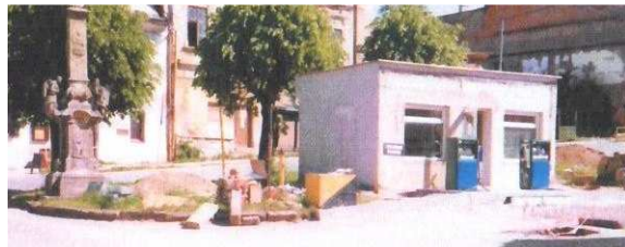
Čerpací stanice před rekonstrukcí
