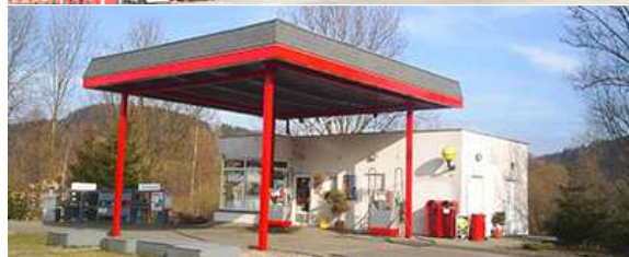
Čerpací stanice v okolí
