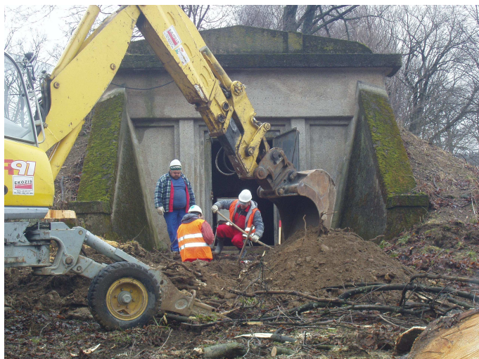
FOTO č.1: Vodojem u koupaliště
