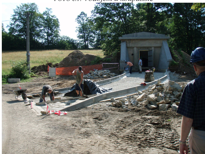
FOTO č.2: Vodojem u koupaliště
