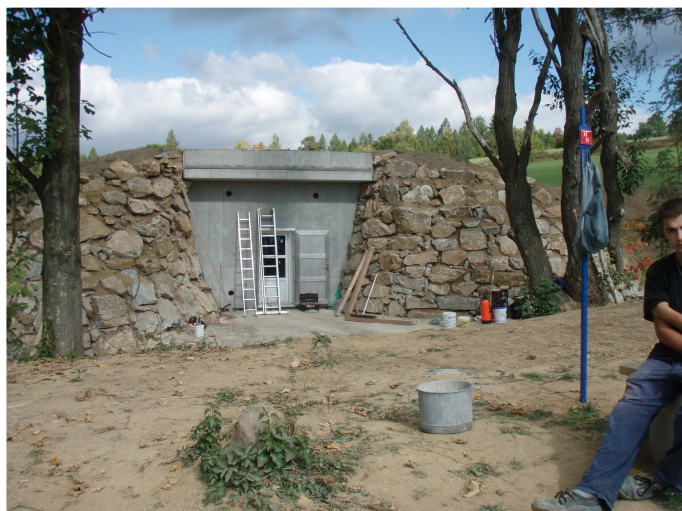
FOTO č.4: Nový vodojem
