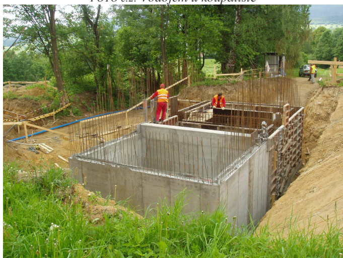
FOTO č.3: Nový vodojem
