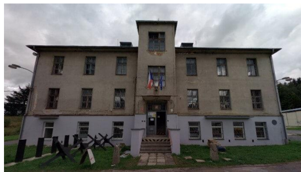
Obr. 22 Bývalá kasárna č. 2
