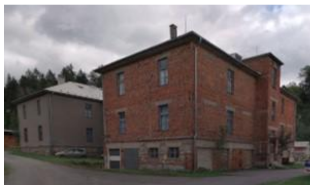
Obr. 24 Bývalá kasárna č. 4
