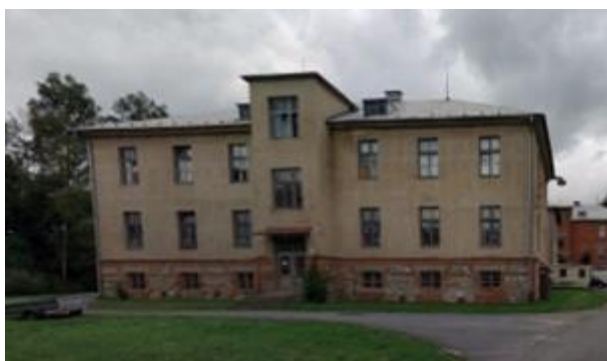
Obr. 23 Bývalá kasárna č. 3
